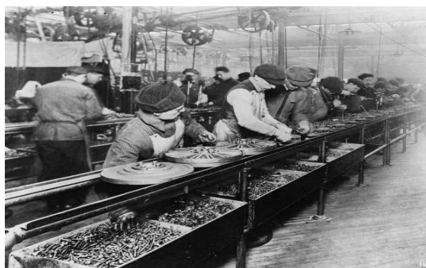
Montážní linka hromadné výroby a slavný T-model Fordu - první „sériově vyráběné“ auto
